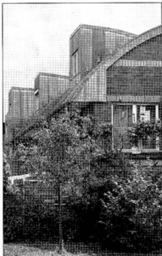
Die Wohnsiedlung in Gerresheim hat viele Gesichter. Halbtonnen ersetzen schräge Dächer (l.), ein Turm markiert die Ecke von Reihenhäusern.
